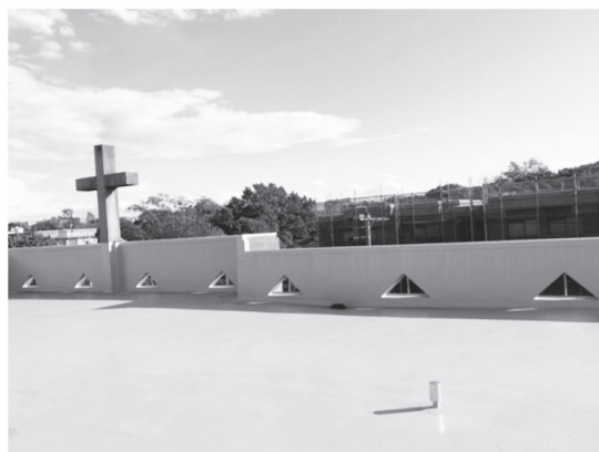
図4. ライネルス館屋上
