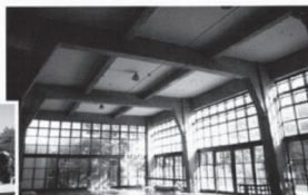
聖母女学院・小生用雨天体育場・内部
