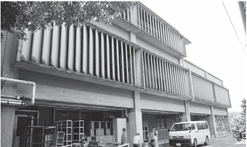
プレキャストのブリーズソレイユ。西側からの日除けと、通風をよりよく得るための工夫。清々しいリズム感がある。この食堂棟でのデザインモチーフが大学全体に展開された。
