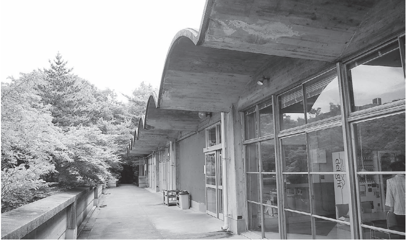
アーチ型の波打底。3階からブリッジへと継がるテラス。
