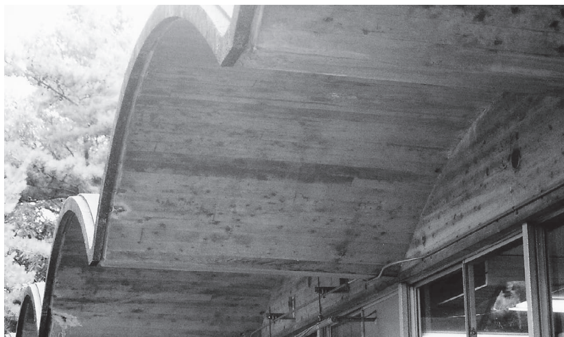
アーチ型の波打つ庇が美しい。このアーチ型はおそらく大学会館屋根のドーム（球状シェル）から発想されたものであろう。
