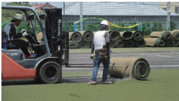
人工芝張り替え工事の様子
