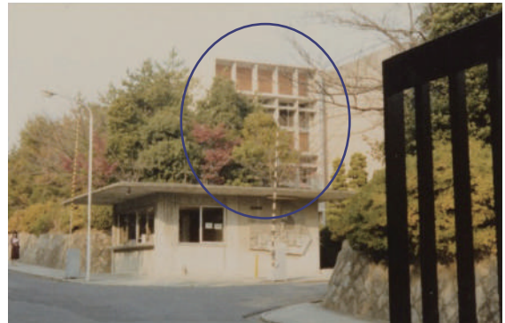
大学本部管理棟（増築後）
